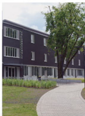
Abb. 3: Eine Altbauweise wurde 2013 zur gut gedämmten Plusenergieschule mit Wärmepumpe und Photovoltaikanlage, die übers Jahr mehr Energie erzeugt, als die Nutzer fürs Heizen und die Elektrizität benötigen. Die Unihochschule in Stuttgart-Zuffenhausen. Foto: Baris
