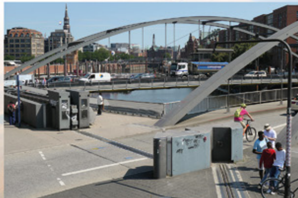
Abb. 4: Ein verschließbares Hochwasserschutztor in Hamburg
