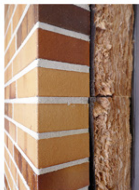
Abb. 4: Fassadendämmung am Ferdinand-Porsche-Gymnasium in Stuttgart Foto: Baris
