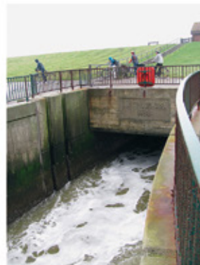
Abb. 3: Deich mit Flussmündung. Welchem Meeresspiegelanstieg kann man mit höheren Deichen noch trotzen? Das hängt auch davon ab, wie Flüsse bei steigendem Meeresspiegel noch ins Meer gelangen können.
